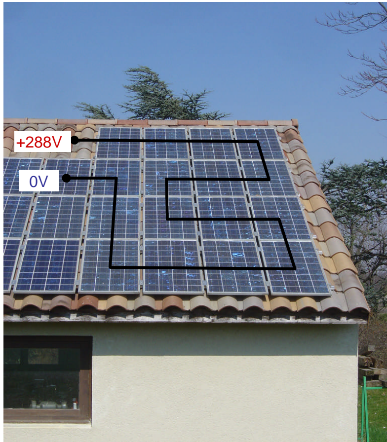
16 modules photovoltaïques en série
