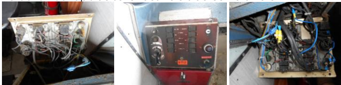
Réfection du câblage de la platine du tableau de bord gauche
