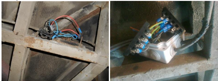
Réfection des connexions du câblage d'alimentation des feux arrière
