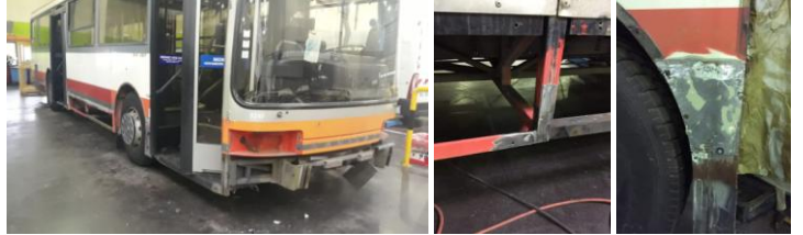
▲ - Les tôles buguées, déformées ont pu être retouchées, et les tubulures les plus fragilisées par le temps se situant autour des passages de roue. Lorsqu'une section est trop abîmée, elle est éliminée à la disqueuse pour une section de profilé neuf. Cette lutte contre la rouille a retardé le chantier et alourdi le temps de travail prévu sur le devis Les bas de caisse sont les zones les plus vulnérables à la corrosion Le métal débarrassé de la rouille se retrouve à nu - © Jérôme Bonato ▼ - Autour des roues, les commandes de secours accumulent dépôts et sources d'humidité, responsables de la rouille. Le cadre du chariot à batteries a également été repris - © Jérôme Bonato
